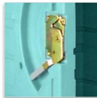
Cierre rápido de 2 puntos tipo «pelicano» de acero galvanizado bicromatado
